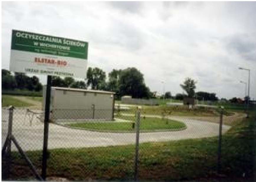
Zdjęcie: Oczyszczalnia ścieków typu SBR w miejscowości Wichertów
